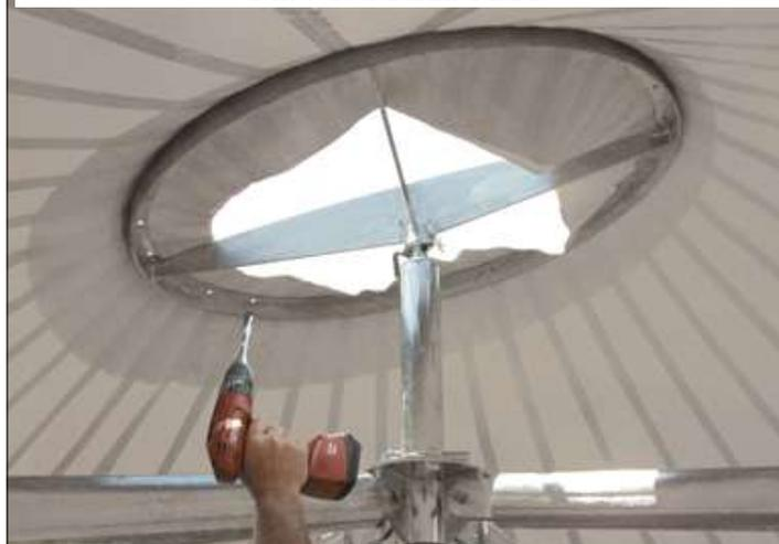
**26)** CON L'AIUTO DI UNA CORDA, TIRARE DALL'INTERNO DELLA STRUTTURA IL CERCHIO PER IL FISSAGGIO DEL TELO.
